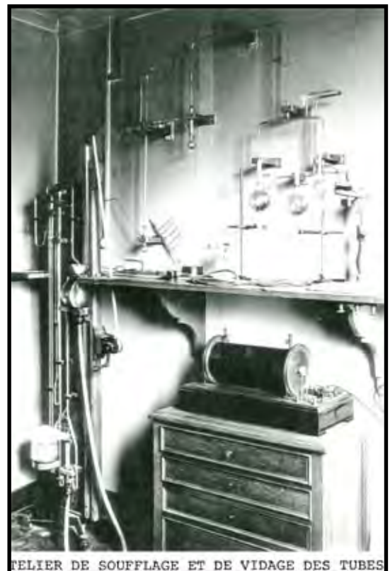
ATELIER DE SOUFFLAGE ET DE VIDAGE DES TUBES
